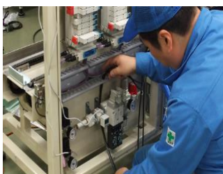
コンセントが壊れた
