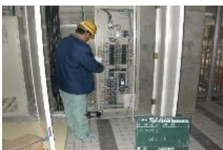
高圧～低圧へ変更工事
