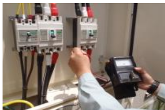
漏電改修工事
