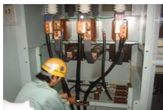
高圧ケーブル工事
