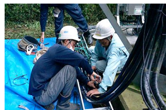
高圧引込工事
