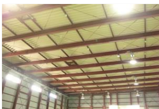
LED(高効率)照明工事
