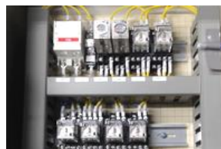
ブレーカーの増設
