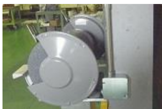
コンセントの増設
