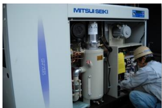
動力設備工事
